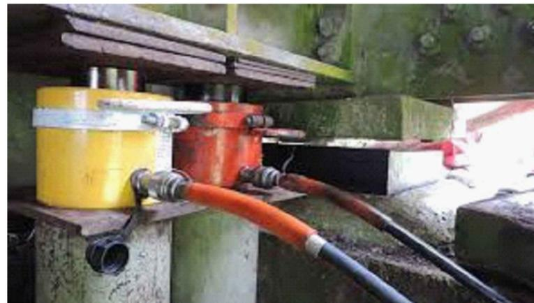
PENEMPATAN DAN PEMASANGAN POSISI DONGKRAK APABIAL KAPASITAN DONGKRAK TIDAK MEMADAI DIPASANG 2 BUAK PADA SATU TITIK
